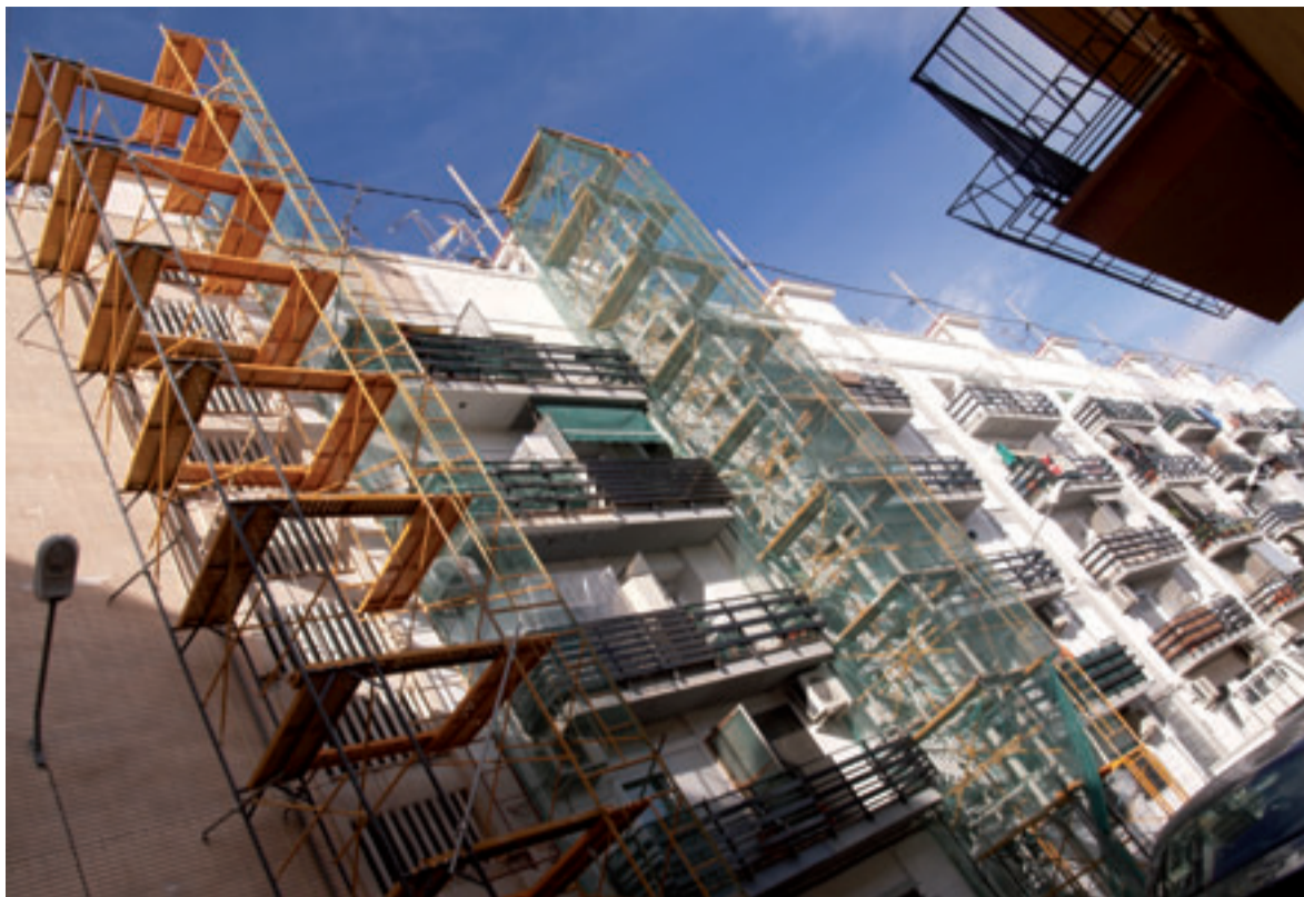
Obres d'instal·lació d'ascensors a l'edifici Vistabella
